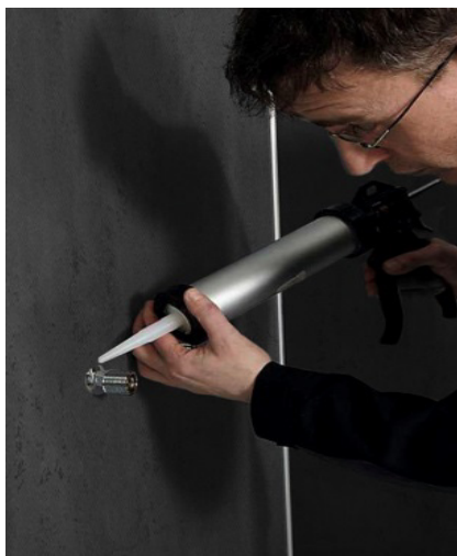
3.17 Durchführungen mit essigsäurefrei vernetzendem Naturstein-Silikon abdichten.
